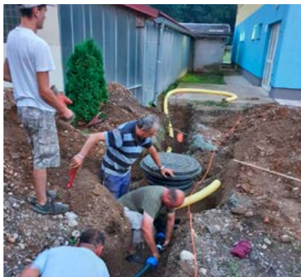
ŠP DOBROVCE – IZVEDBA KANALIZACIJE S PREČRPALIŠČEM vrednost: 5.502 EUR
