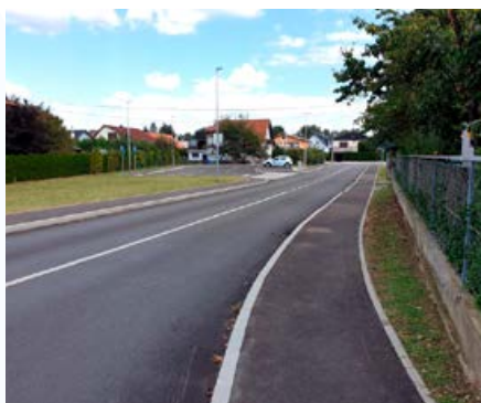
GRADNJA NOVE POVEZOVALNE CESTE MED ULICO KIRBIŠEVIH IN PTUJSKO CESTO
